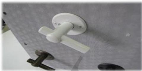
Смещение оси штока шибера, клапана (пример)
